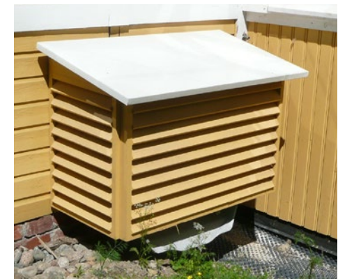
Hyvin suunniteltuna nykyaikainen talotekniikka voidaan toteuttaa historiallisessa ympäristössä lähes huomaamattomasti. Yläkuvassa ilmalämpöpumpun suojakotelo ja alakuvassa tekninen laite sekä johto rakennusaineisessa, julkisivun väriin maalatussa kotelossa.
